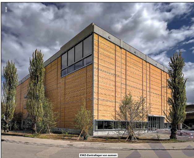
EWZ-Zentrallager von aussen
